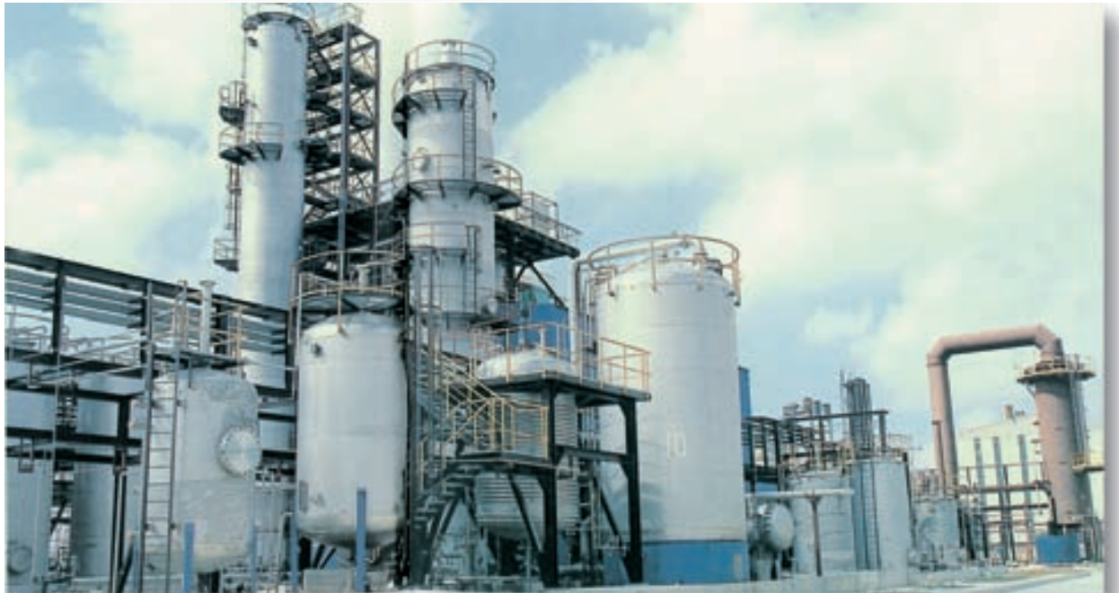
Hidrojen peroksit kimya fabrikası
